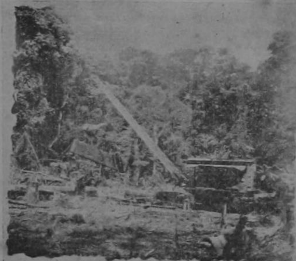
La potente excavadora, apartando grandes trozos de madera
