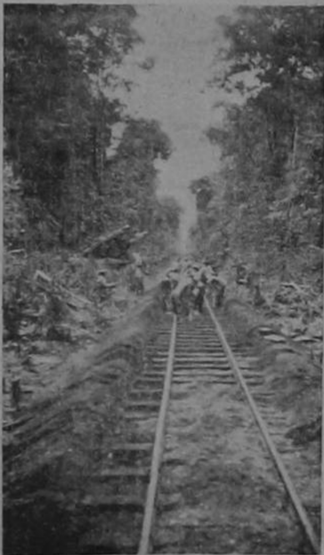
Trabajadores distribuyendo el balasto en el nuevo ramal
